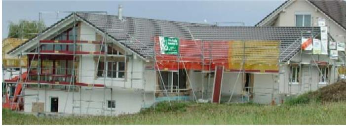
Bauelemente, ähnlich wie früher Backsteine, oder andere Fertigbauelemente, zu einem Haus zusammengefügt, wobei alle Vorgaben des Architekten bereits im Vorfeld entsprechend programmiert und millimetergenau zugeschnitten worden sind.
